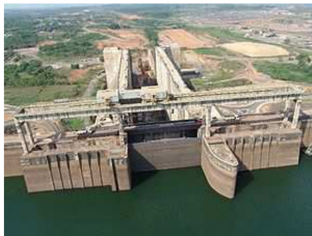
Ilustração 15 - Eclusa de Tucuruí em Construção
